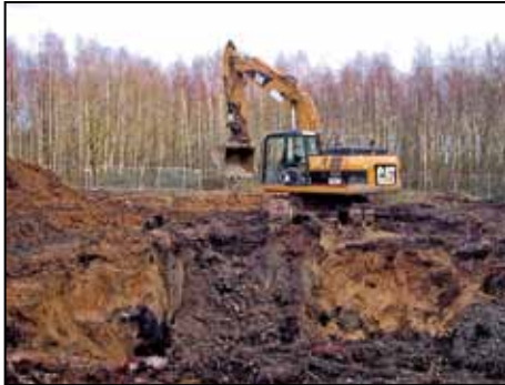
Der Bagger im Einsatz.
